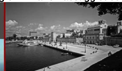
Insediamento di Alghero in posizione contigua al sistema portuale
